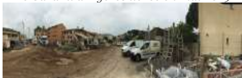
Chantier de la résidence sociale Le Carami à Hyères livrée en mai 2019
